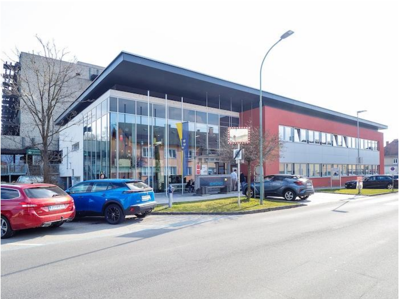
Das Landeskrankenhaus Gmünd soll laut NÖ Gesundheitspakt geschlossen werden. (Bild: Klaus Schindler)
